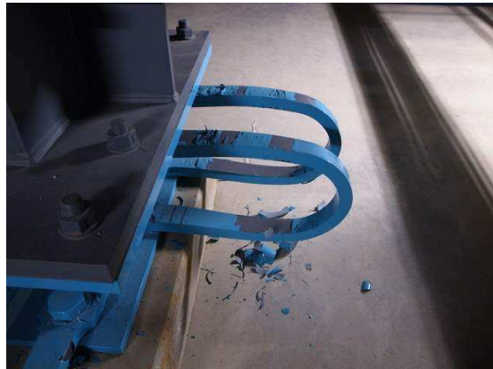
(d) Trace of movement of sliding damper
